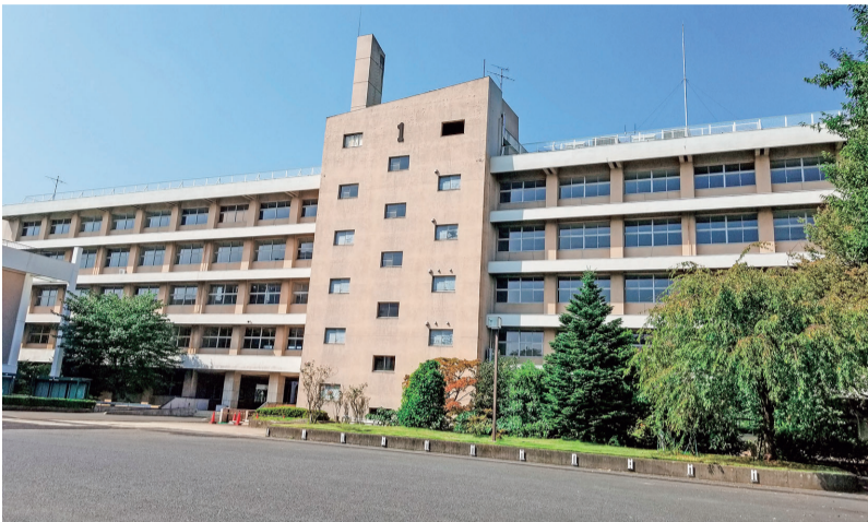
▲間もなく取り壊される旧1号館 (10月2日撮影)
